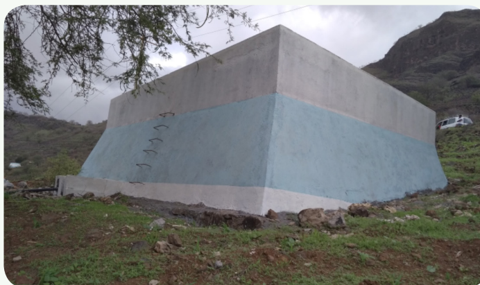
Reservatório Djambam— 50m 3
